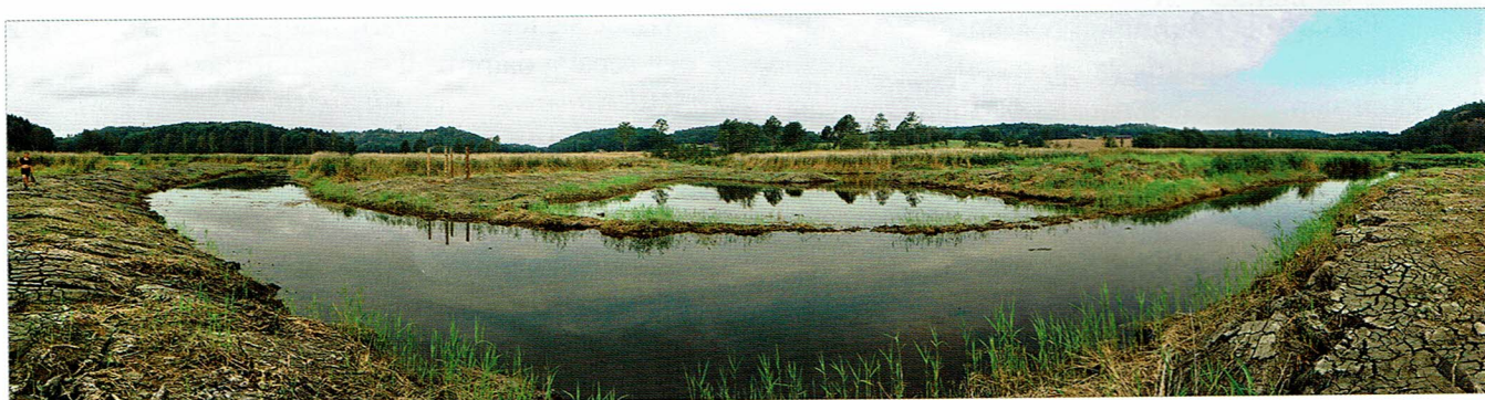
Den nyanlagda dammvallen. Foto: Jan Wijkmark.
